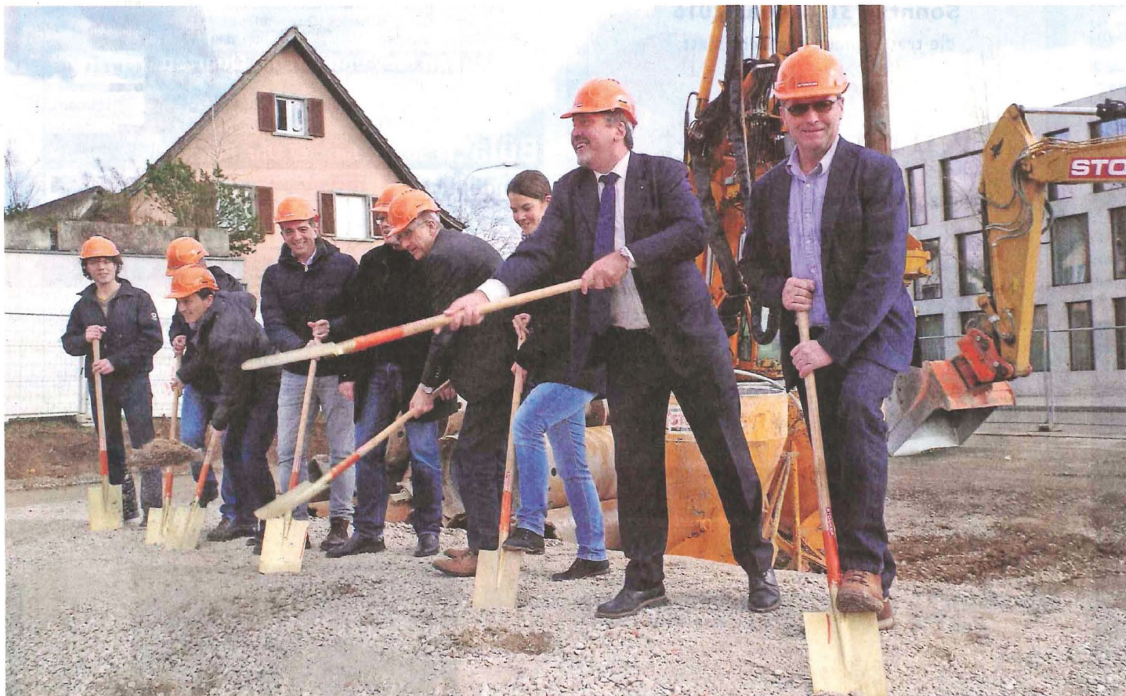
Sie alle legten sich beim Spatenstich mächtig ins Zeug: Bauingenieur Thomas Hofer, Leiter Liegenschaften Daniel Raschle, Architekt Martin Eglin, Gemeindeschreiber Stefan Pfyl, Bauingenieur Peter Hohn, Haustechnikplaner Fredy Meier, Sachbearbeiterin Liegenschaften Franziska Hildebrandt, Gemeindepräsident Max Walter und Bauvorstand Karl Wegmüller (von links).
